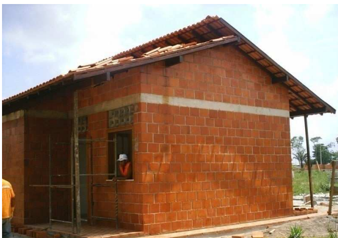
Figura 4 – Casa construída com resíduo do processo Bayer.
