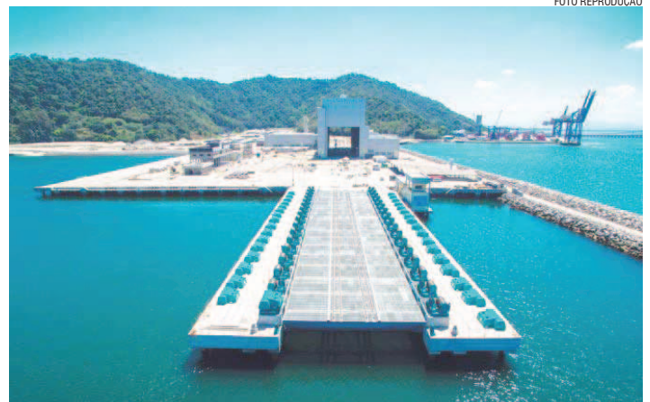
AS OBRAS do estaleiro de construção e do elevador de navios ganharam prioridade no Prosub
