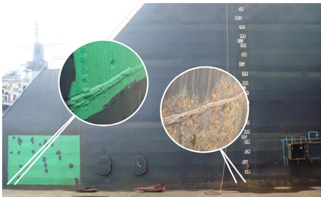
Costado do Dique “Almirante Schieck”, com e sem a aplicação da Tinta Ferrugem Protetora®
