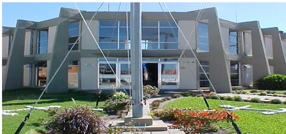
Prédio da CPRS - vista frontal
