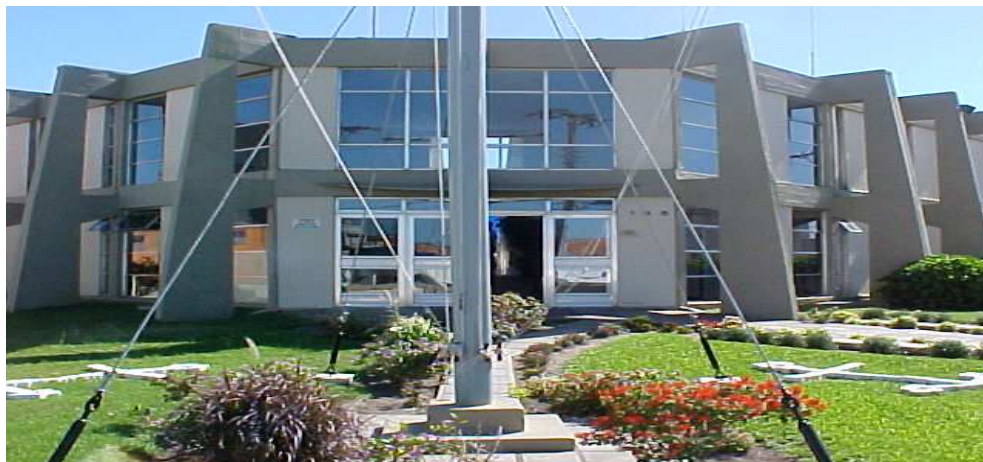
Prédio da CPRS - vista frontal
