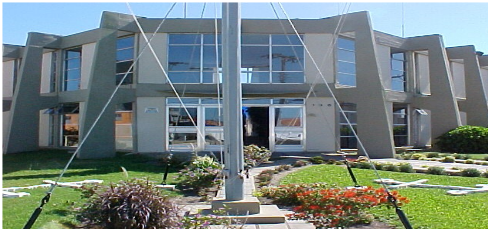
Prédio da CPRS - vista frontal
