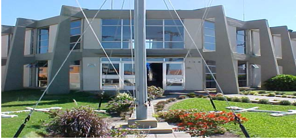
Prédio da CPRS - vista frontal
