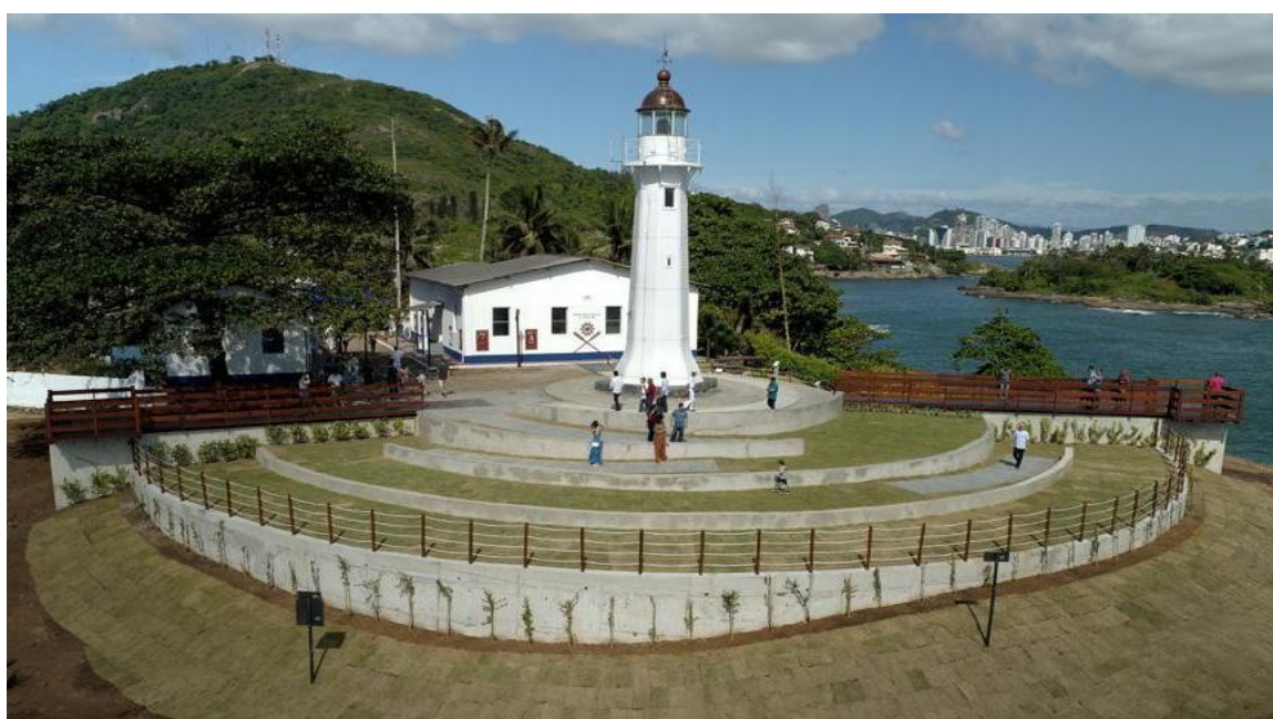
O Farol Santa Luzia foi reaberto ao público no último dia 21 de dezembro, após obras de qualificação do espaço (Fotos: Vitória Drones)
