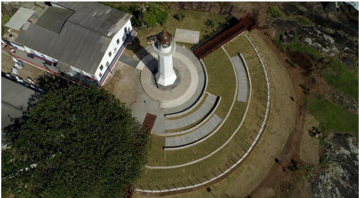
O Farol Santa Luzia visto de cima, após obras de qualificação do espaço (Fotos: Vitória Drones)
