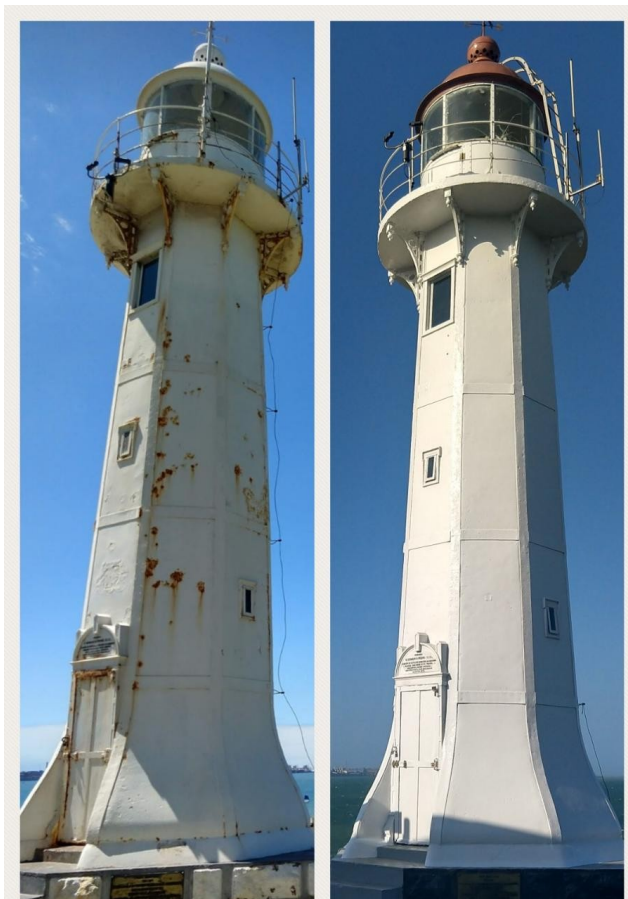
Farol Santa Luzia, antes e depois da pintura.
