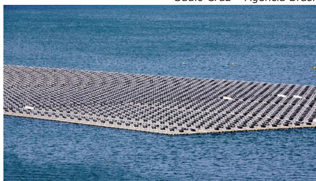
Painéis solares flutuando sobre o lago de Sobradinho.
