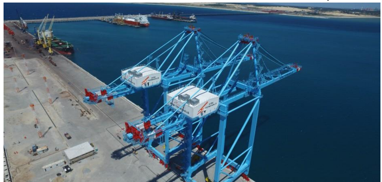
Guindastes do tipo STS no porto do Pecém.
