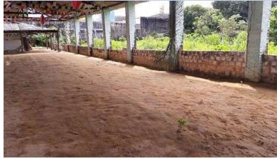
Panorâmica da estrutura da Sede.
