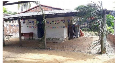
Panorâmica da estrutura da Sede.
