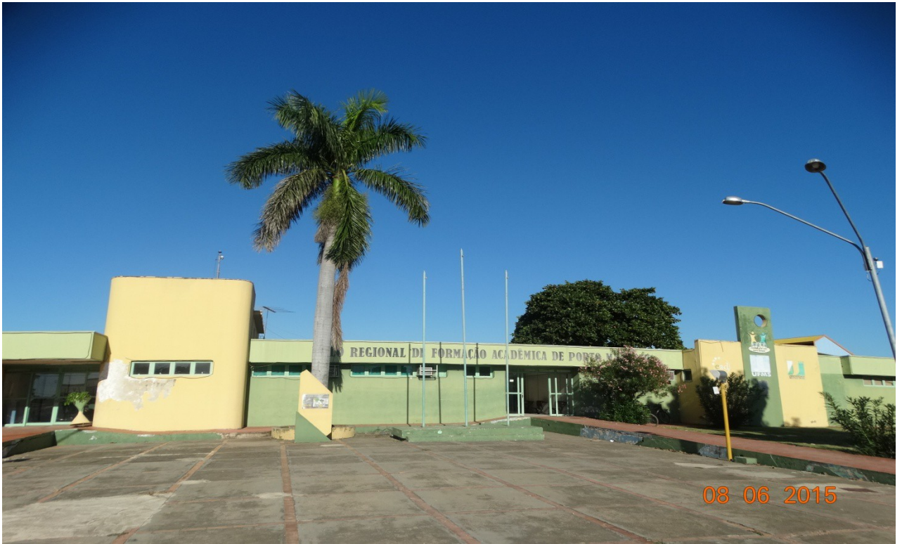
Antes das Obras
